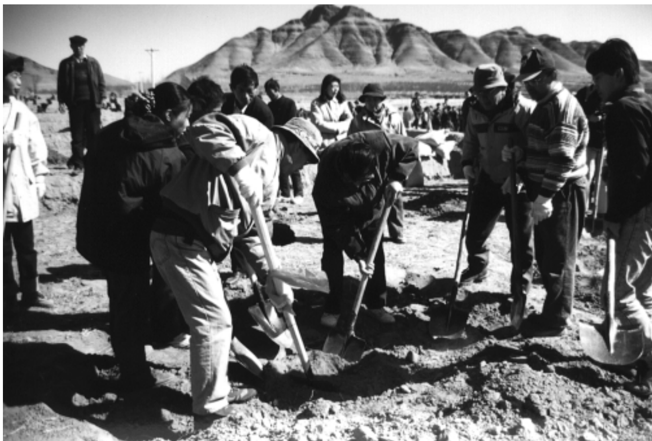
豊丘県落水河郷三山村で植樹作業。深さ80cmに掘った穴を、表土で途中まで埋め返してから植樹する
