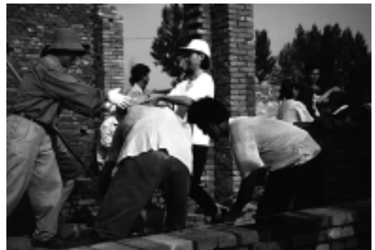
天鎮県趙家溝村で小学校建設のレンガ運びを手伝う
