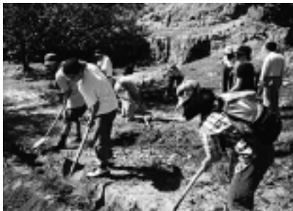
守口堡村で溝掘り
