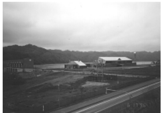
試験湛水中の二風谷ダム
