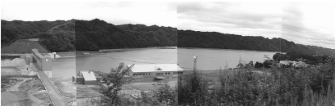
完成してしまった「違法」二風谷ダム
