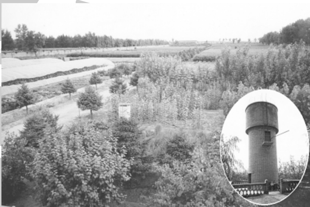
大同の緑化協力の基地・環境林センターでは、井戸に貯水槽をつけるなど整備がすすんでいる
