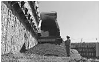
コンクリート碎石の場内利用
