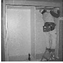
左) 家具ユニット 組み立て 下) プレカット工 法
