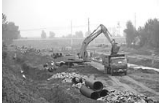
環境林センターの南側ですすむ道路工事
