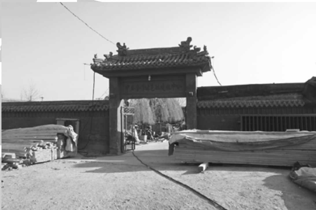
旧環境林センターの管理棟は資材置き場等として利用されている。中庭のシダレニレもそのまま。(P4～5)
