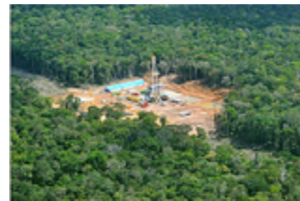
アマゾンの掘削現場
